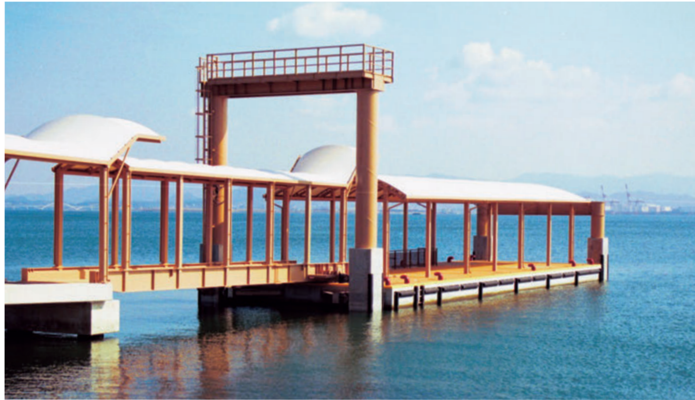
01 船着場【30.0m×10.0m】／福岡県福岡市 博多港西戸崎地区
