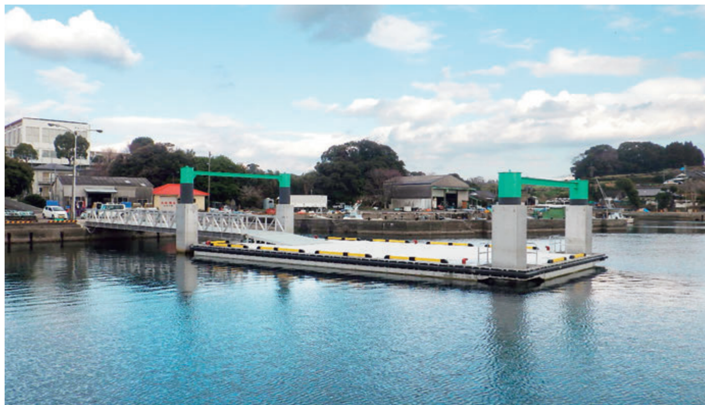
06 物揚場 [25.5m×13.0m] / 鹿児島県長島町 長島港伊唐地区
