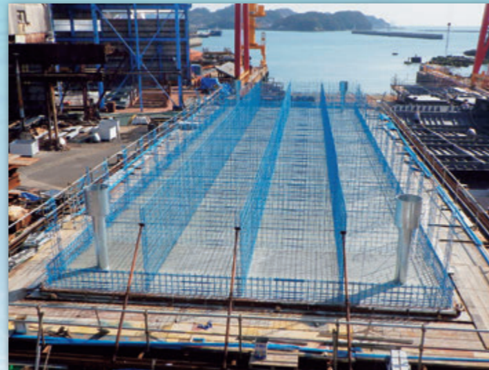
2. 底盤コンクリート
