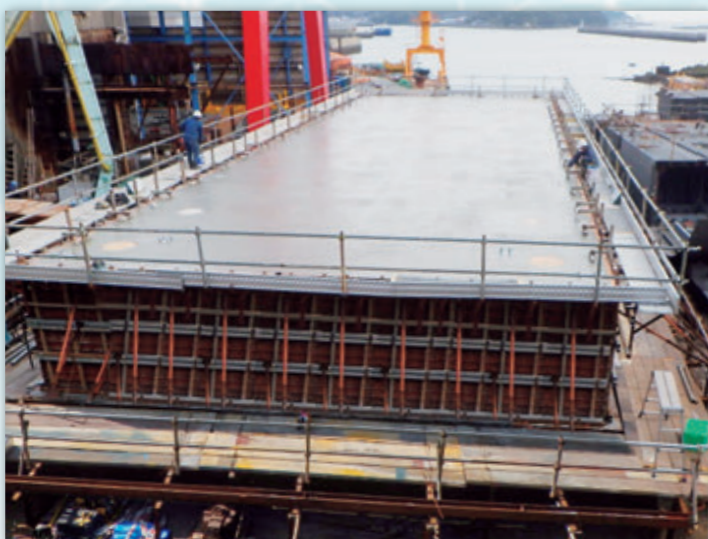
5. 床版、側壁・隔壁コンクリート
