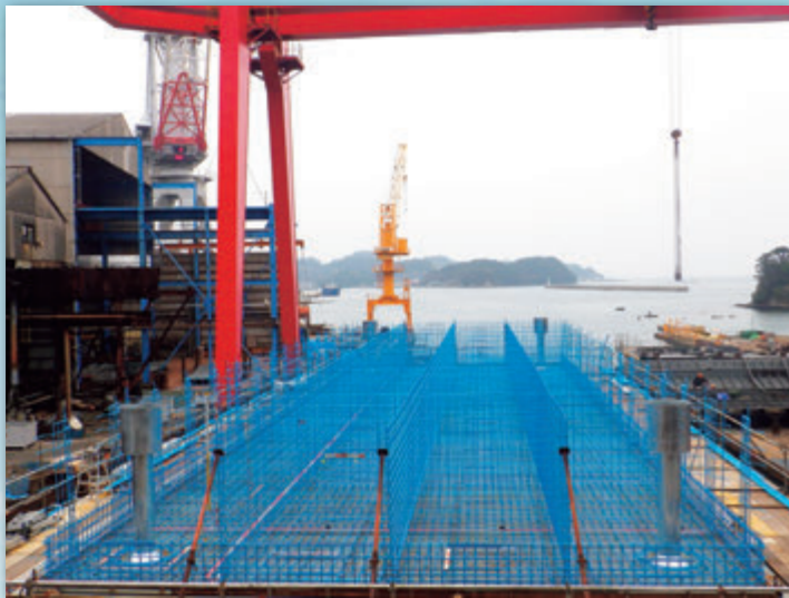
1. 底盤型枠、底盤・隔壁配筋
