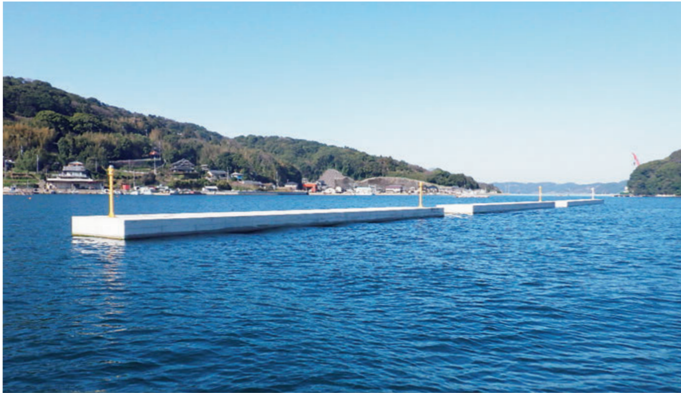
17 浮消波堤【25.0m×3.0m・6基】／長崎県佐世保市 佐世保港浦頭地区
