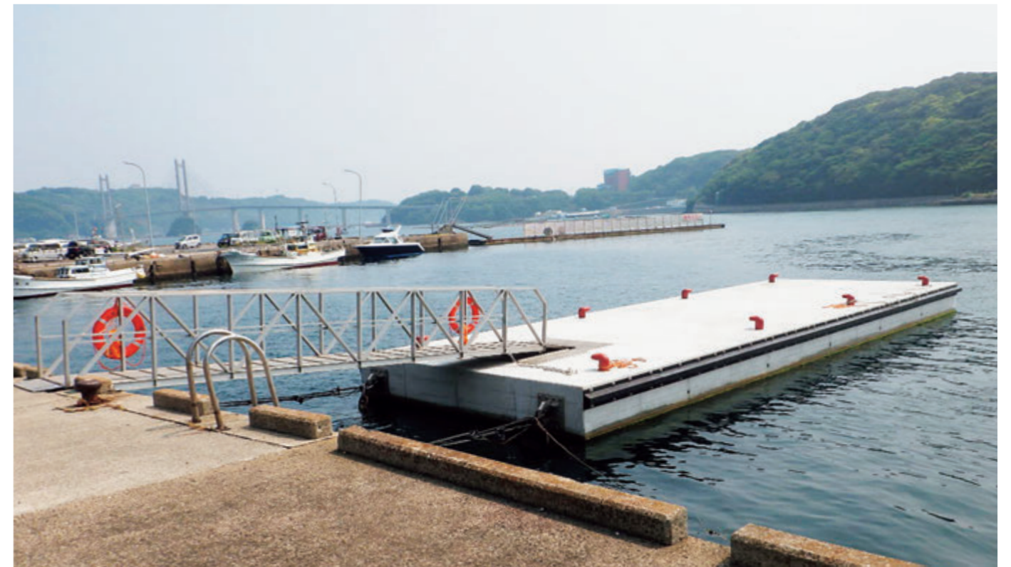
19 漁船係留施設【18.0m×6.0m】／佐賀県唐津市 名護屋漁港
