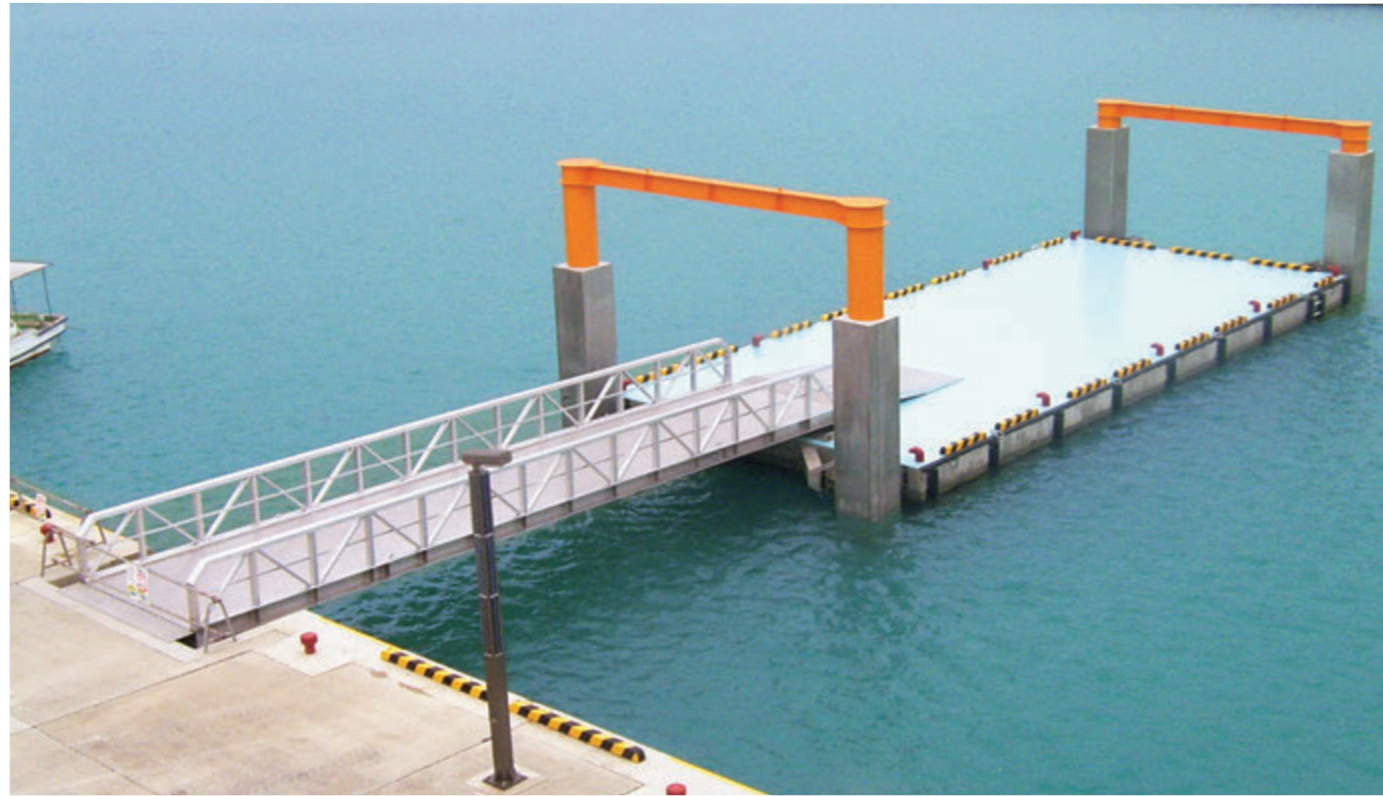
09 物揚場【20.0m×9.0m】／沖縄県宮古島市 池間漁港
