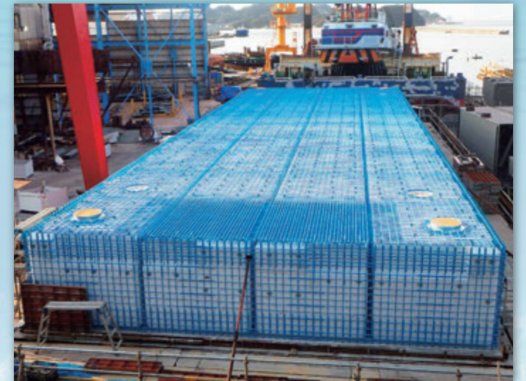
4. 側壁・床版・配筋
