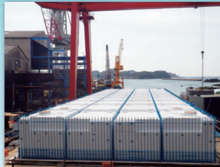
3. 発泡スチロール設置
