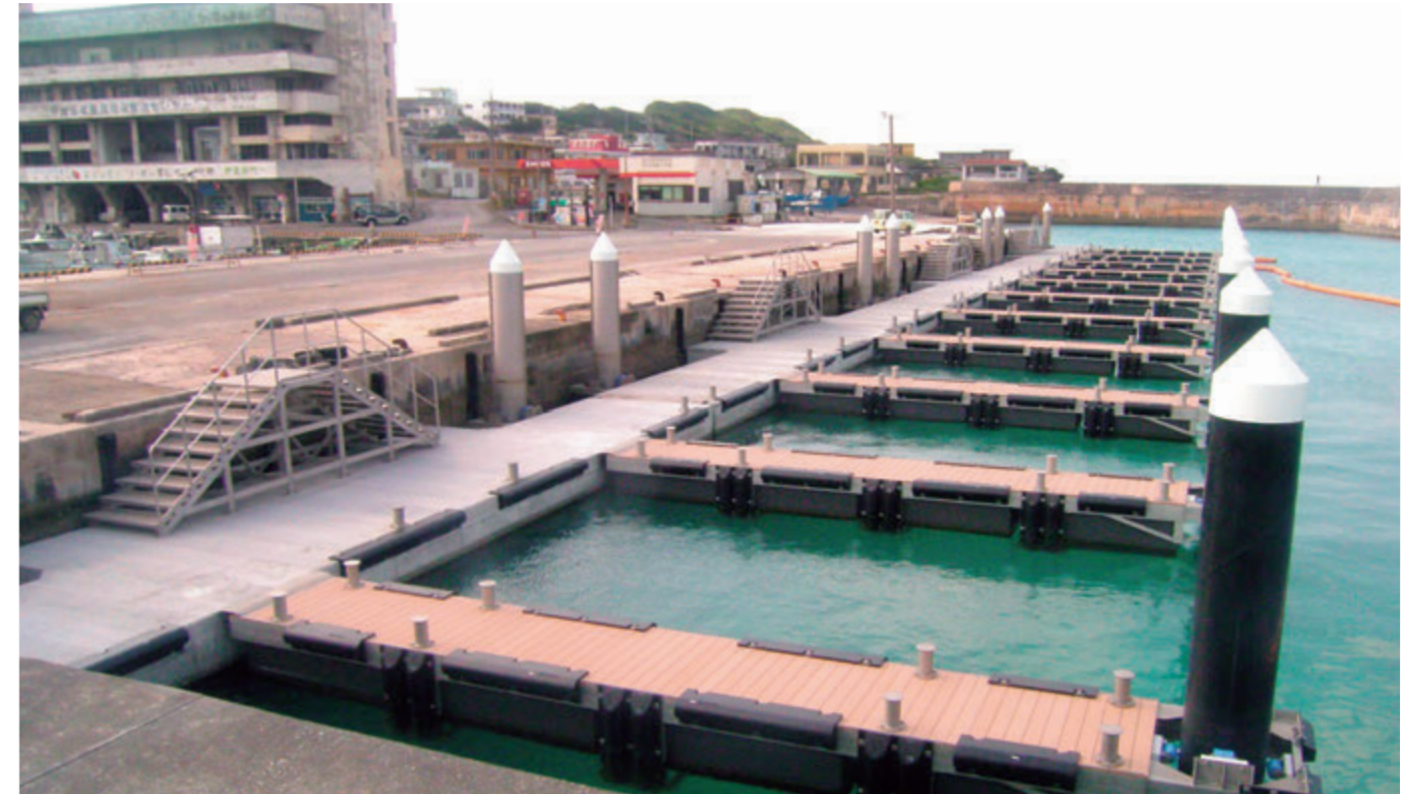
15 休憩【25.35m×4.5m・3基】【16.85m×4.5m・1基】【11.0m×1.5m・11基】／沖縄県宮古島市 佐良浜漁港
