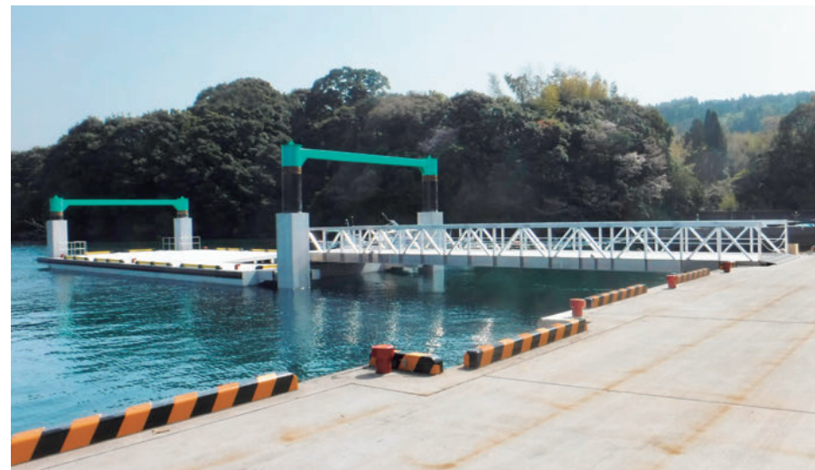
07 物揚場【25.5m×13.0m】／鹿児島県長島町 長島港口之福浦地区
