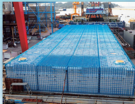
4. 側壁・床版・配筋
