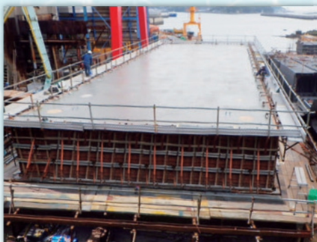
5. 床版・側壁・隔壁コンクリート
