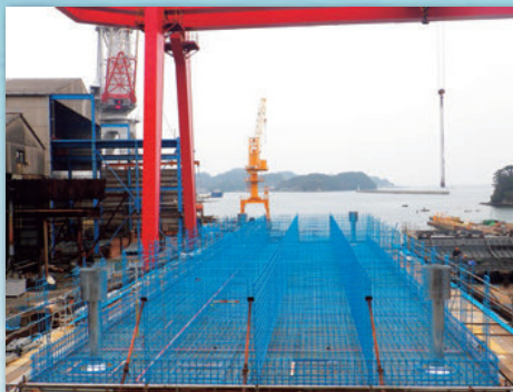
1. 底盤型枠、底盤・隔壁配筋
