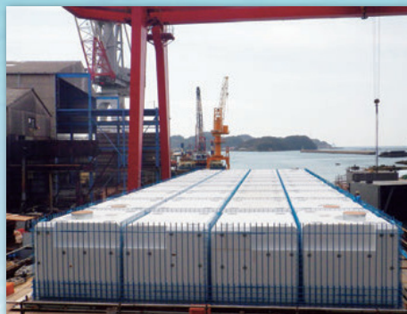
3. 発泡スチロール設置
