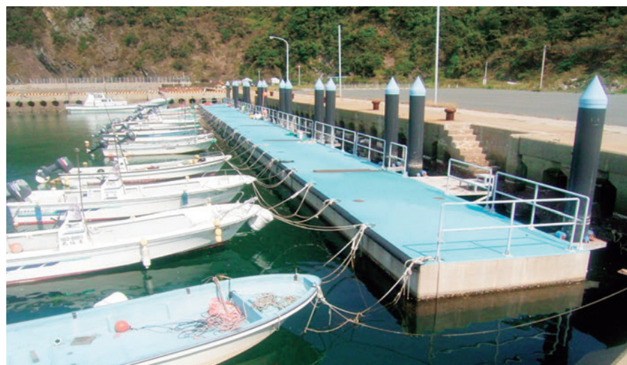
14 物揚場 [10.0m×3.5m・7基] / 長崎県対馬市 久根浜漁港
