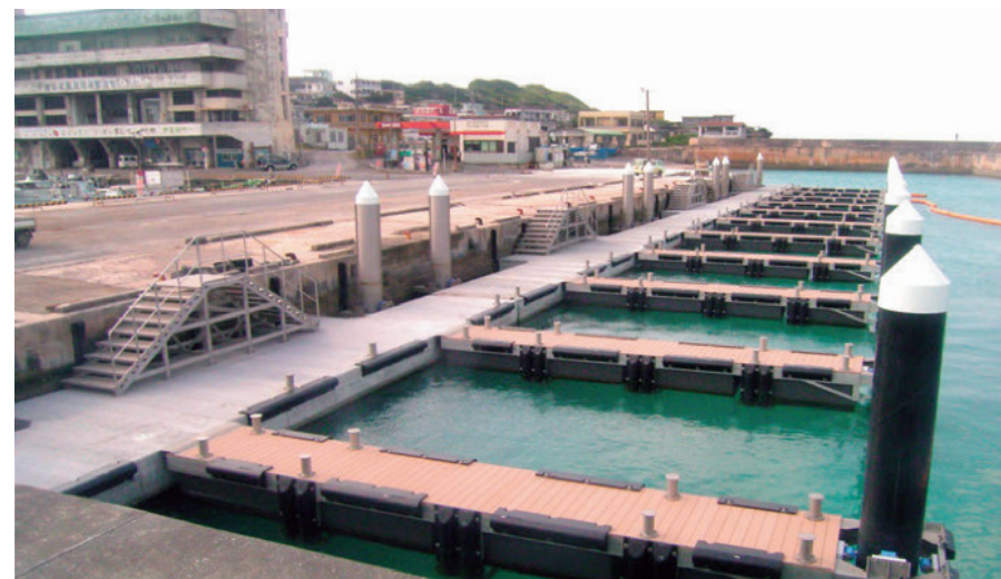
15 休憩 [25.35m×4.5m・3基] [16.85m×4.5m・1基] [11.0m×1.5m・11基] / 沖縄県宮古島市 佐良浜漁港
