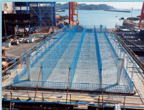
2. 底盤コンクリート
